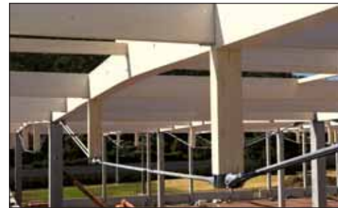
Waldkirch · Cerchas sostenidas
